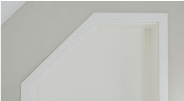
Schrägelement geschlossen (angepasst an Dachschräge)
